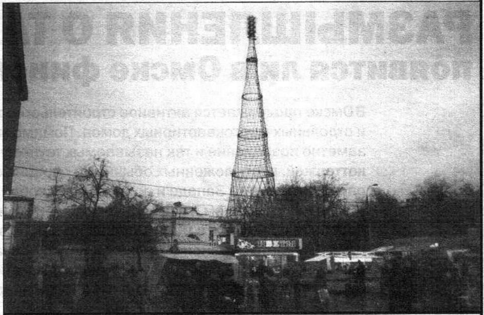
Шуховская башня – первая решетчатая стальная башня. (Шаболовка, г. Москва)
